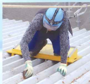
高圧洗浄後下地のケレン
