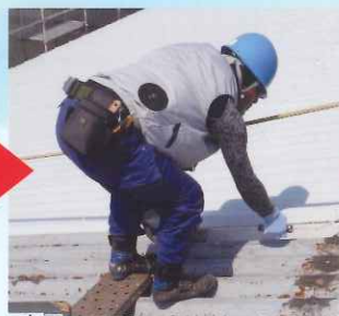
プライマー塗布
